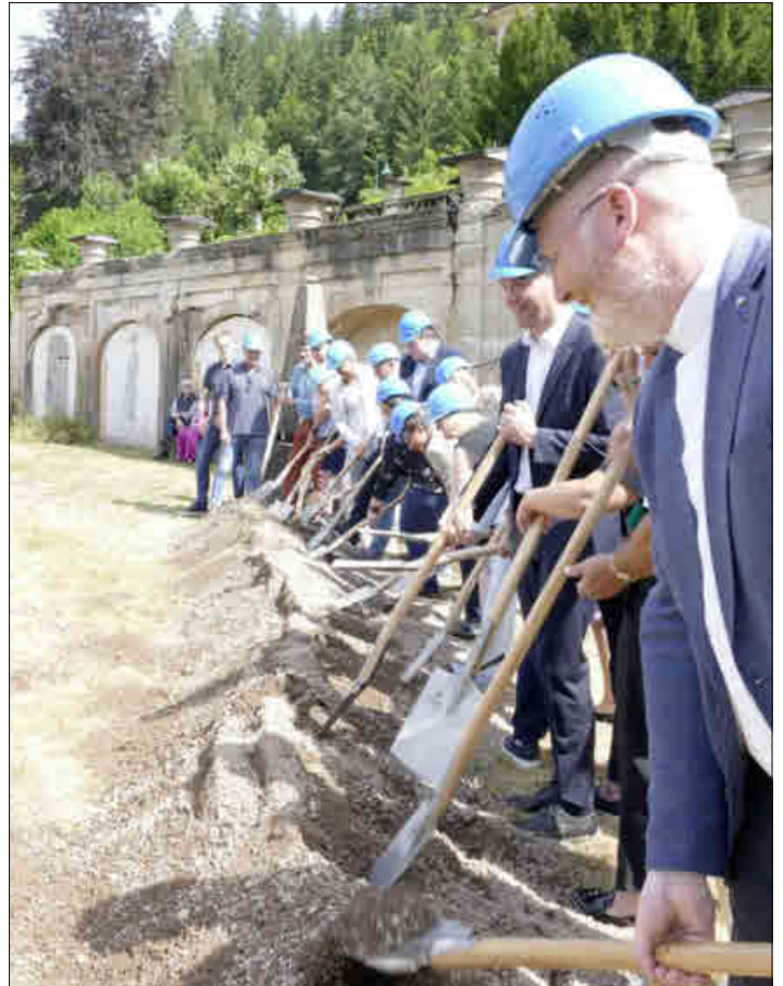
Viele Akteure haben die beiden Sanierungsprojekte möglich gemacht, die am Dienstag mit dem Spatenstich an den Start gegangen sind.
