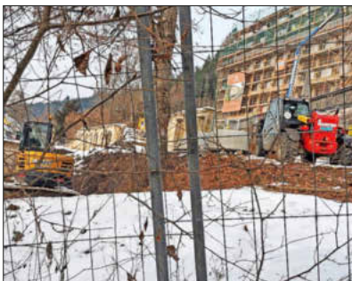
Im Dezember soll im Sanagarten ein weiterer Bauabschnitt angegangen werden.
